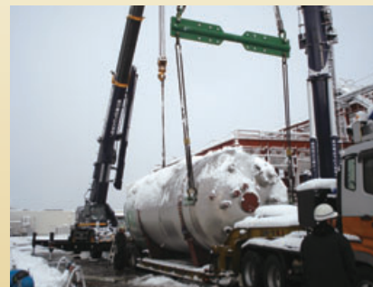
細心の注意を払いながらの大型タンクの搬入作業
