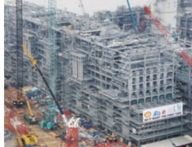
心臓部の「分解炉」10 基の建設工事風景
