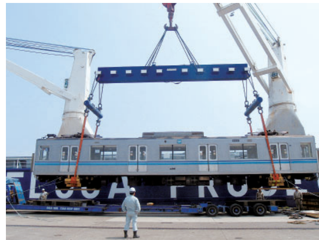
車両を吊り上げて船内へ。空中を運ばれる鉄道車両は珍しい光景
