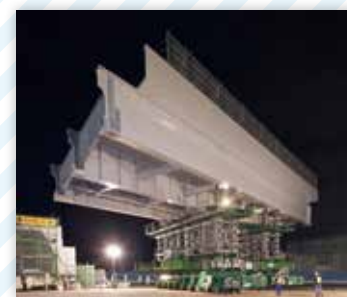
橋梁架設・撤去
