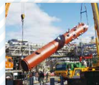
プラント建設・定修(国内)
