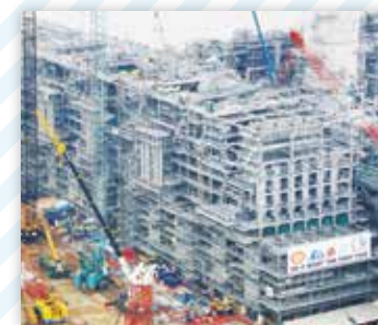
プラント建設・定修(海外)
