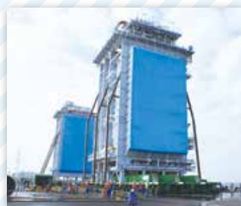
重量物輸送・据付
