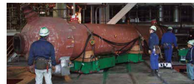
火力発電所給水加熱器取替：約 50ton
