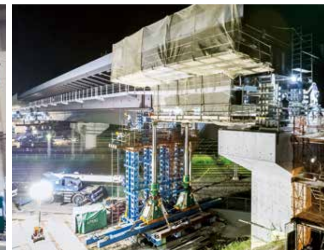
S/L VI, VII 計8台 / 主桁重量 1074ton 長さ 233m (2016年6月)
