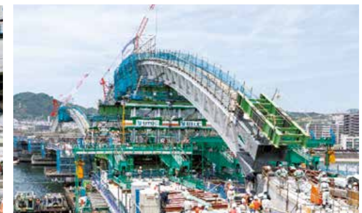
STL Ⅰ 4台 + STL Ⅱ 4台 桁重量 475ton 長さ 約100m (2013年4月)
