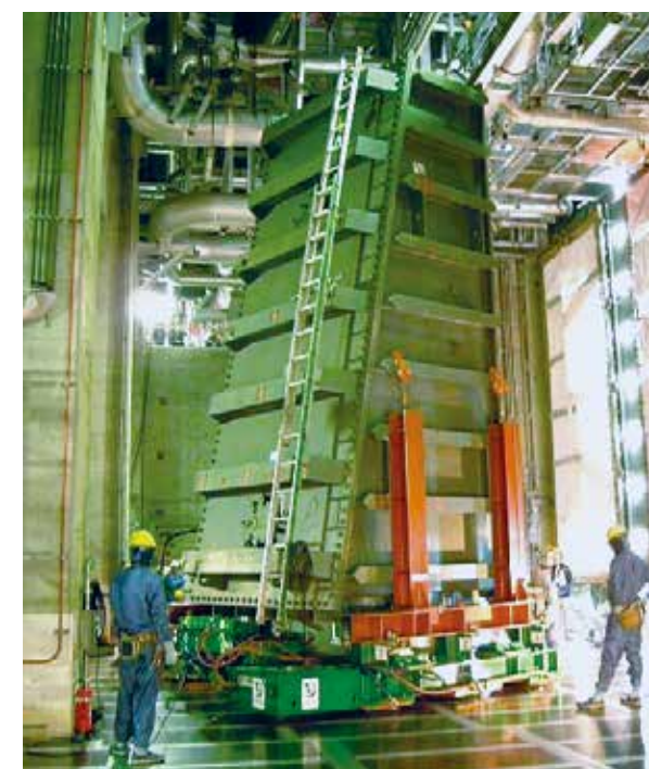
原子力発電所大型機器取替：約 40ton
