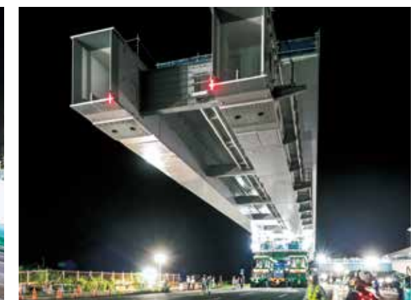
10軸トリプルバイ編成 + STL Ⅱ 4台 桁重量 約670ton (2018年5月)
