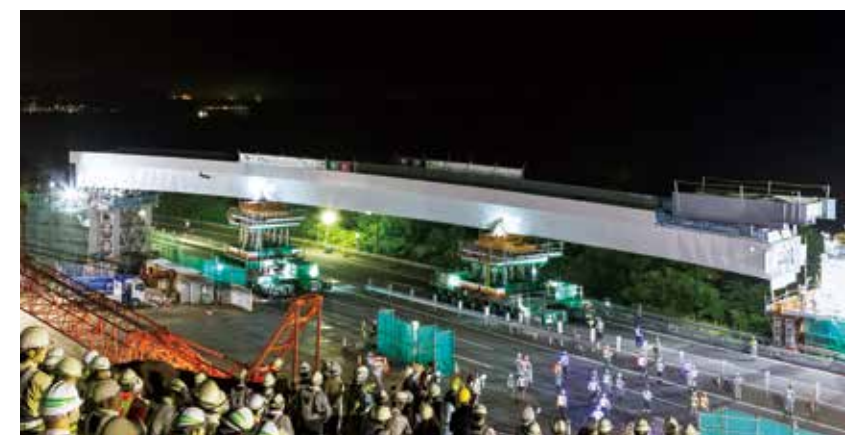
前方8軸サイドバイ編成 + 後方9軸サイドバイ編成 + STL Ⅱ 4台 桁重量 約410ton (2017年6月)
