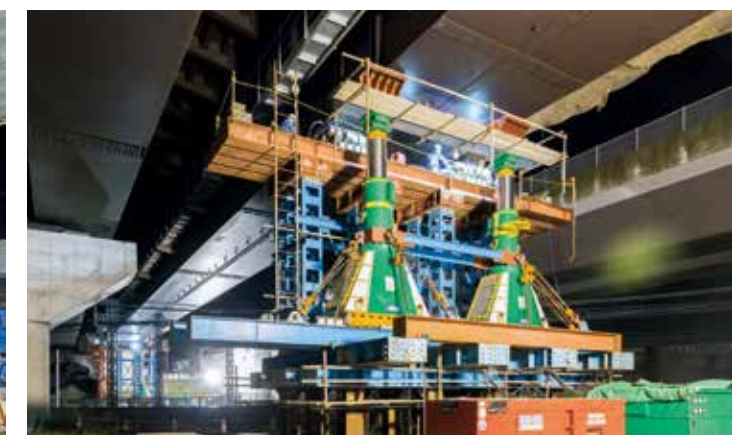
S/L VI, VII 8台 主桁重量 1074 ton (2016年6月)
