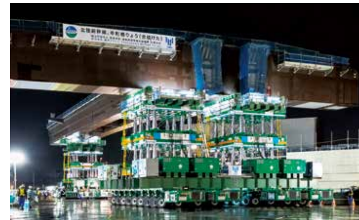
9軸サイドバイ編成 × 3+STL Ⅲ 8台 桁重量 760ton (2019年11月)
