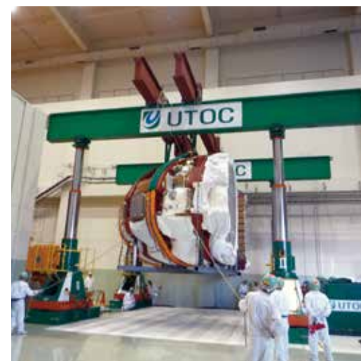
原子力施設機器解体
