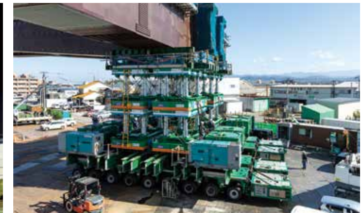
9軸サイドバイ編成 × 3+STL Ⅲ 8台 桁重量 760ton (2019年11月)
