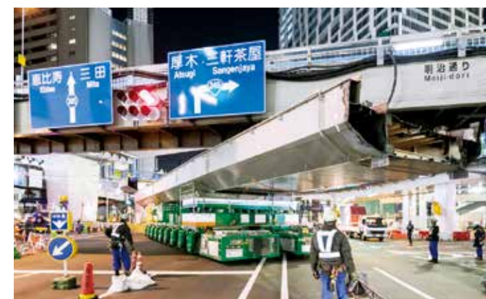
9軸サイドバイ編成 + STL Ⅱ 2台 桁重量 約85ton (2017年2月)
