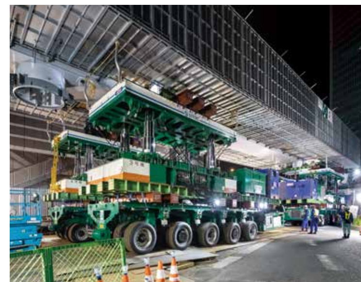
5軸サイドバイ編成×4 桁重量 77ton
