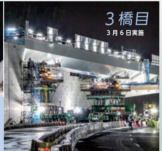
3橋目は、橋桁の重量が1橋目や2橋目より軽いため、摩擦力低下により受け点がずれる傾向にあり、水平調整を行う必要がありました。また、3橋目のみスーパーキャリアにてボルト締め作業まで行いました。平面位置や高さ、傾斜の微調整を行い、ボルトが入る精度まで合わせ工事は無事に完了いたしました。
