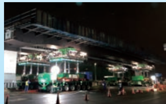
箱桁を2列編成で輸送する様子
