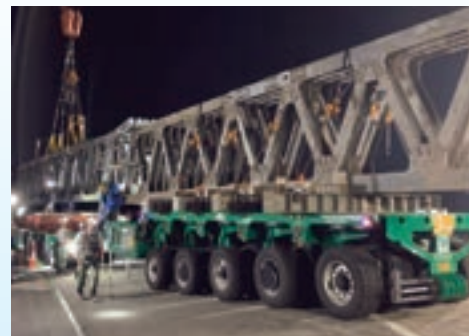
応急桁輸送の様子
