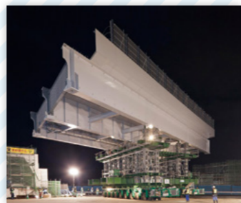
橋梁架設・撤去
