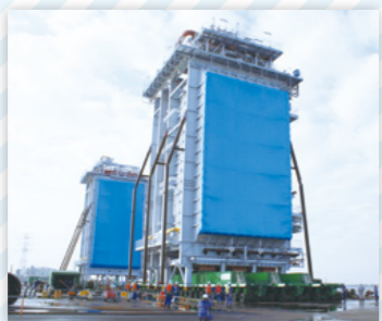
重量物輸送・据付
