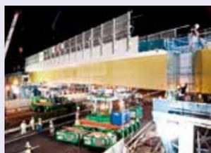
超重量物を水平かつ鉛直に短時間で動かしたい。そんなご要望にお応えするのが「スーパーキャリア」と「スーパーテーブルリフト」の組み合わせです。「スーパーキャリア」上に「スーパーテーブルリフト」を積載することで、どこまでも輸送可能となる他、荷台上に積載の「スーパーテーブルリフト」によって高所へせり上げが可能となります。例えば、橋梁の大ブロック架設は、地組みした橋梁の下部へ「スーパーキャリア」が潜り込み、「スーパーテーブルリフト」によってせり上げと架設もできることで、大幅なコストダウンを実現します。
