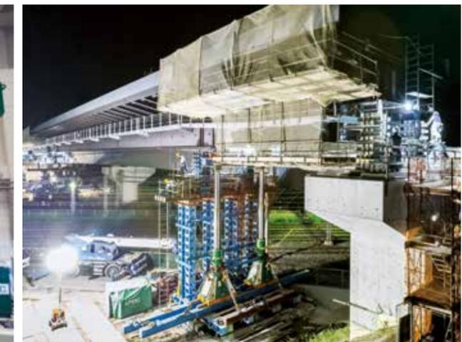
S/L VI, VII 計8台 / 主桁重量1,074ton 長さ233m (2016年6月)
