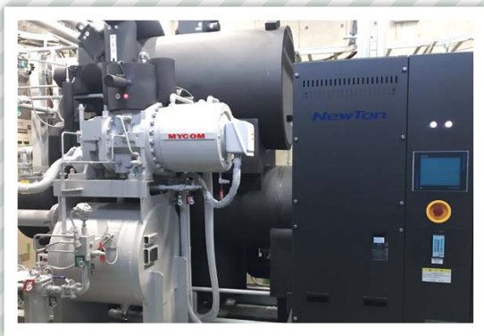
地球温暖化防止の取り組みとして、冷蔵倉庫の冷却設備を 温室効果の高いフロンガスを使用する機器から自然冷媒を 使用する機器（ノンフロン冷凍機）に切り替え
