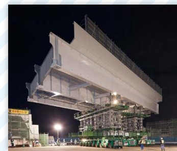
橋梁架設・撤去
