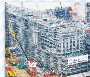
プラント建設・定修(海外)
