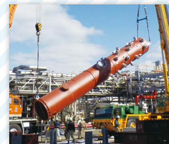
プラント建設・定修(国内)
