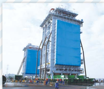
重量物輸送・据付
