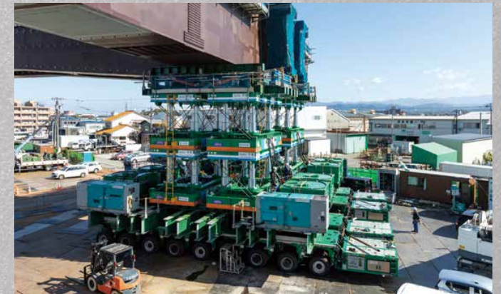
9軸サイドバイ編成 × 3+ テーブルリフト 8 台 桁重量 760ton (2019 年 11 月)
