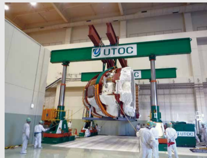
原子力施設機器解体
