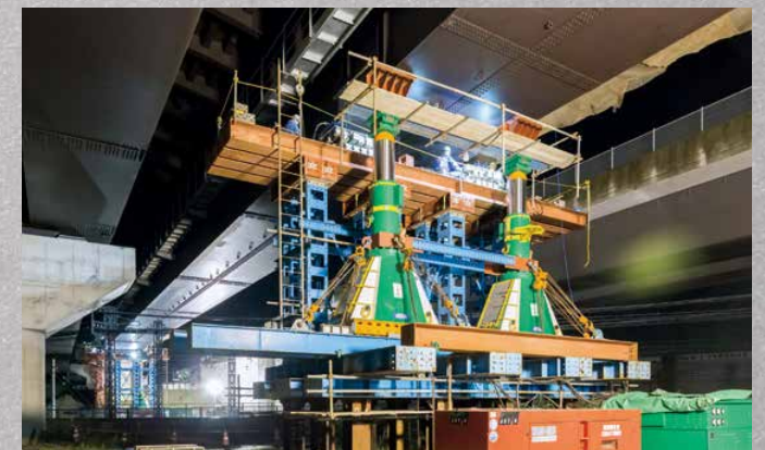
スーパーリフト 8 台 主桁重量 1,074 ton (2016 年 6 月)
