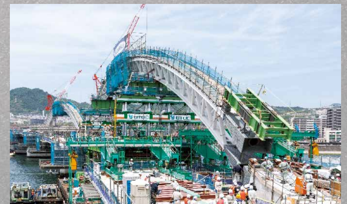
テーブルリフト 4 台 × 2 桁重量 475 ton 長さ 約 100 m (2013 年 4 月)
