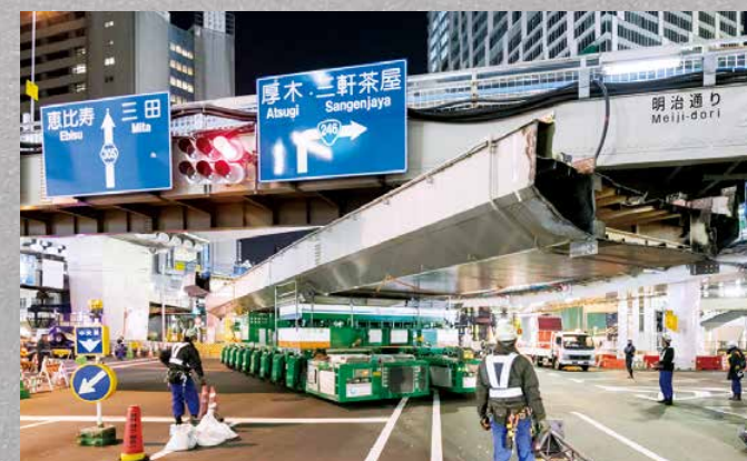
9 軸サイドバイ編成 + テーブルリフト 2 台 桁重量 約 85 ton (2017 年 2 月)
