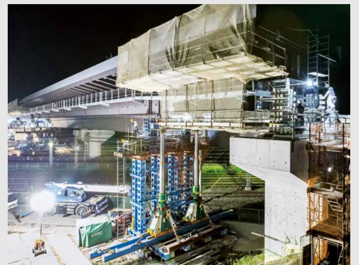
スーパーリフト 計8台 / 主桁重量 1,074ton 長さ 233m (2016年6月)
