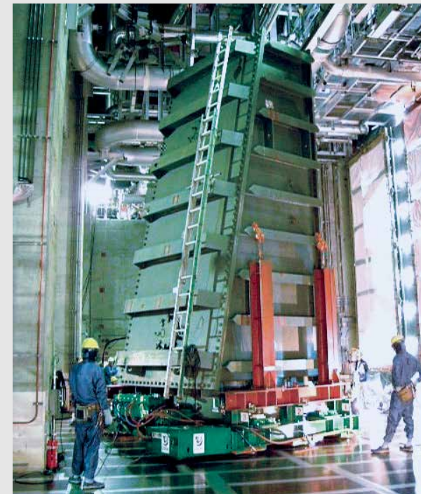
原子力発電所大型機器取替：約 40ton
