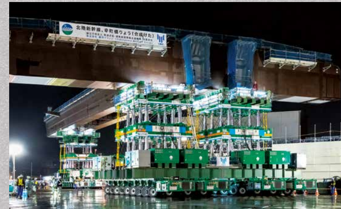
9軸サイドバイ編成 × 3+ テーブルリフト 8 台 桁重量 760ton (2019 年 11 月)
