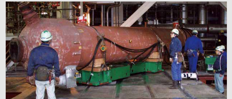
火力発電所給水加熱器取替：約 50ton
