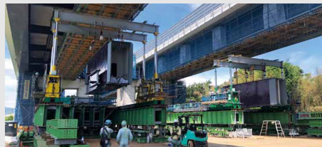
高速道路下での橋梁拡幅工事
