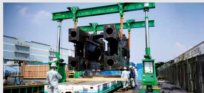
大型プレス器部材 荷役作業
