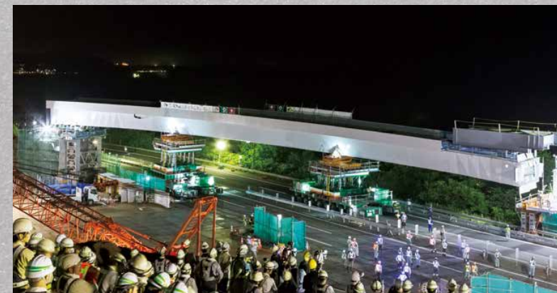
前方 8 軸サイドバイ編成 + 後方 9 軸サイドバイ編成 + テーブルリフト 4 台 桁重量 約 410 ton (2017 年 6 月)
