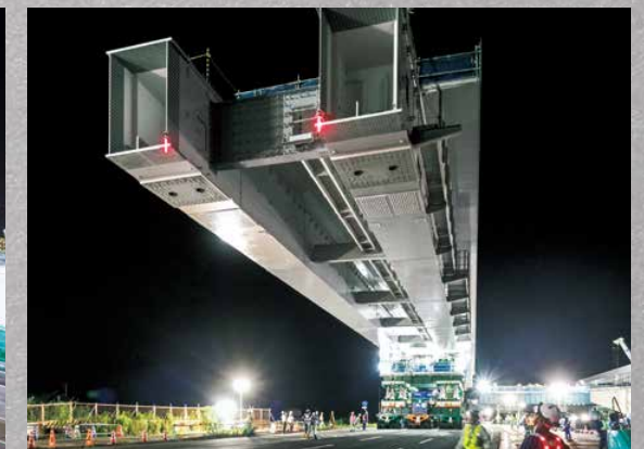
10 軸トリプルバイ編成 + テーブルリフト 4 台 桁重量 約 670 ton (2018 年 5 月)
