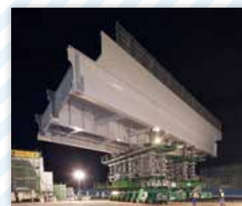
橋梁架設・撤去
