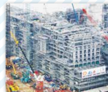
プラント建設・定修(海外)
