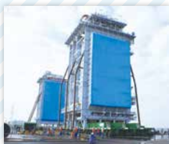
重量物輸送・据付
