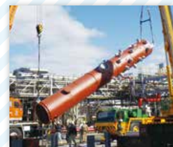
プラント建設・定修(国内)
